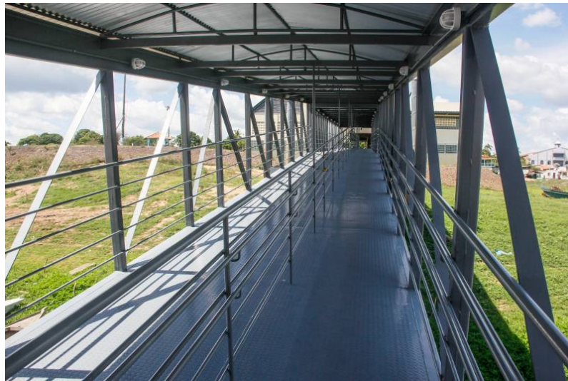
Figura 34 - Rampa metálica articulada de acesso ao terminal
