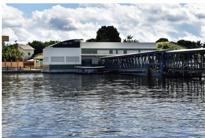
Figura 54 – Imagem da fachada posterior
