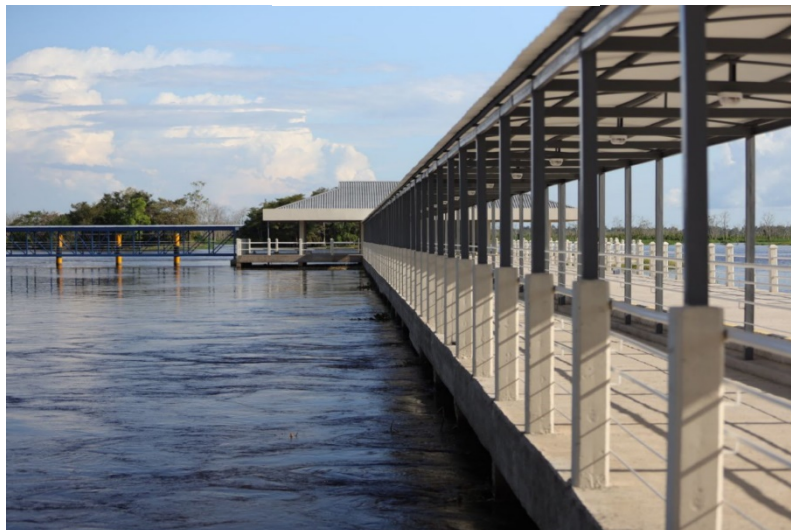
Figura 38 - Passarela de concreto
