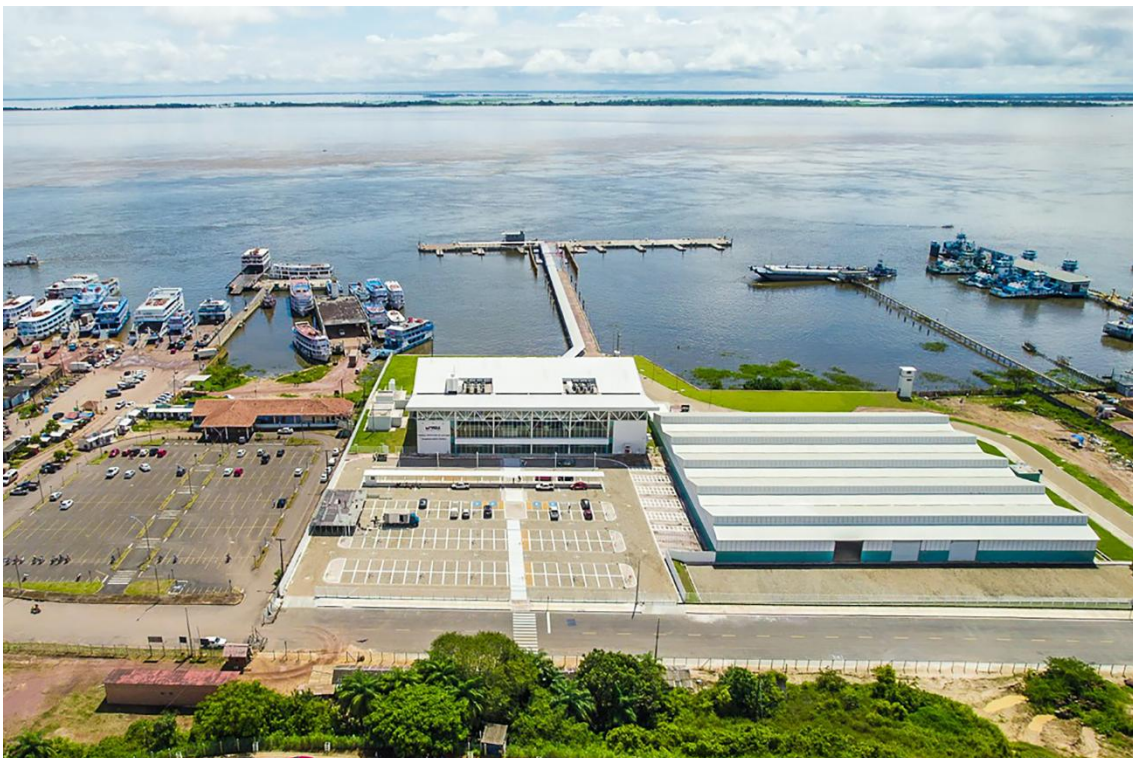
Figura 12 - Terminal Hidroviário de Passageiros e Cargas de Santarém – Joaquim da Costa Pereira, no Baixo Amazonas, situado às margens do rio Tapajós.
