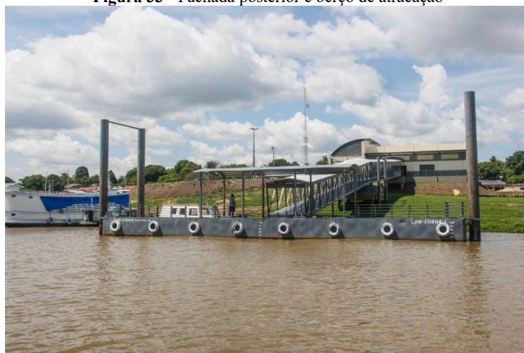
Figura 33 - Fachada posterior e berço de atracação
