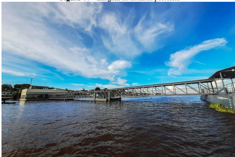
Figura 44 – Imagem da fachada posterior
