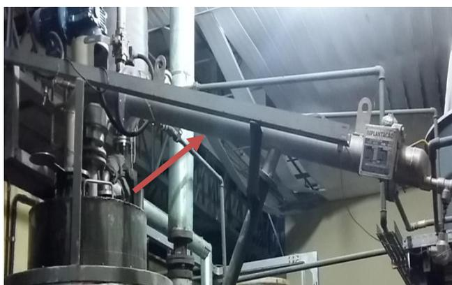
Figura 21 – Trocador de calor multitubular
