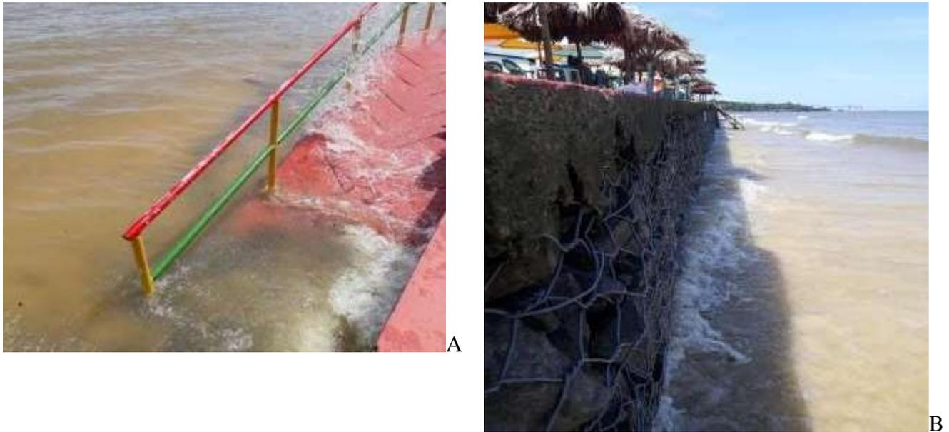
Figura 9 – Ilustração do efeito da maré alta nos meios de passagem de pedestres à praia (A) e no muro de gabião (B) em Setembro de 2019.
