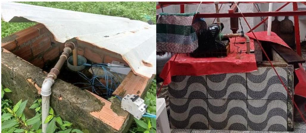
Figura 22- (a) Poço fechado tubular da Agência Distrital da Vila de Algodal e (b) poço aberto localizado em uma pousada da vila.
