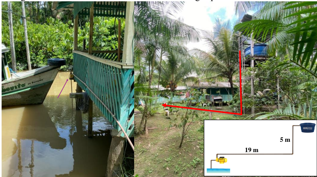
Figura 5.18 – Conexões hidráulicas da bomba d'água presente na residência R.3.
