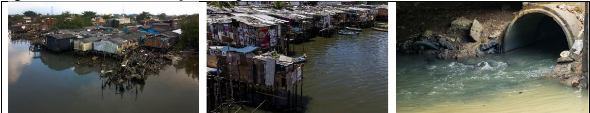
Figura 2 – Palafitas e a situação do esgotamento sanitário
