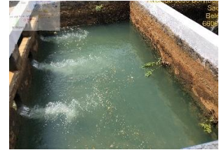
Filtro que se tornou caixa de passagem (ETA São Brás)
