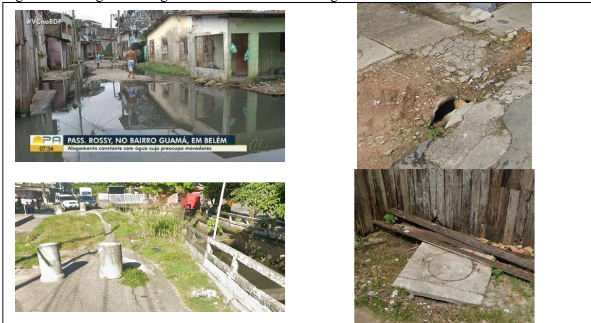
Figura 18 – Registro fotográfico do cenário da drenagem urbana no DAGUA
