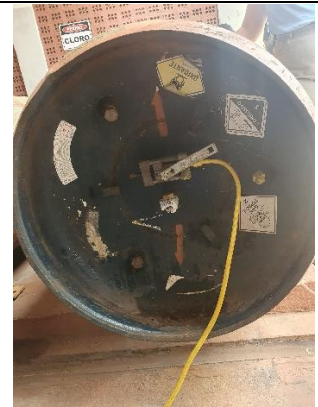
Tambor de armazenamento de cloro para desinfecção (ETA São Brás)
