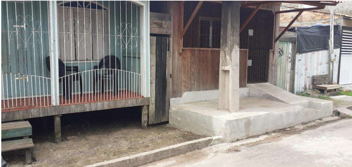
Figura 19 – Padrão das residências, novas e antigas, acima do nível das vias. Passagem São Marçal, entre a Rua Pedro Raiol e a Passagem São Pedro.
