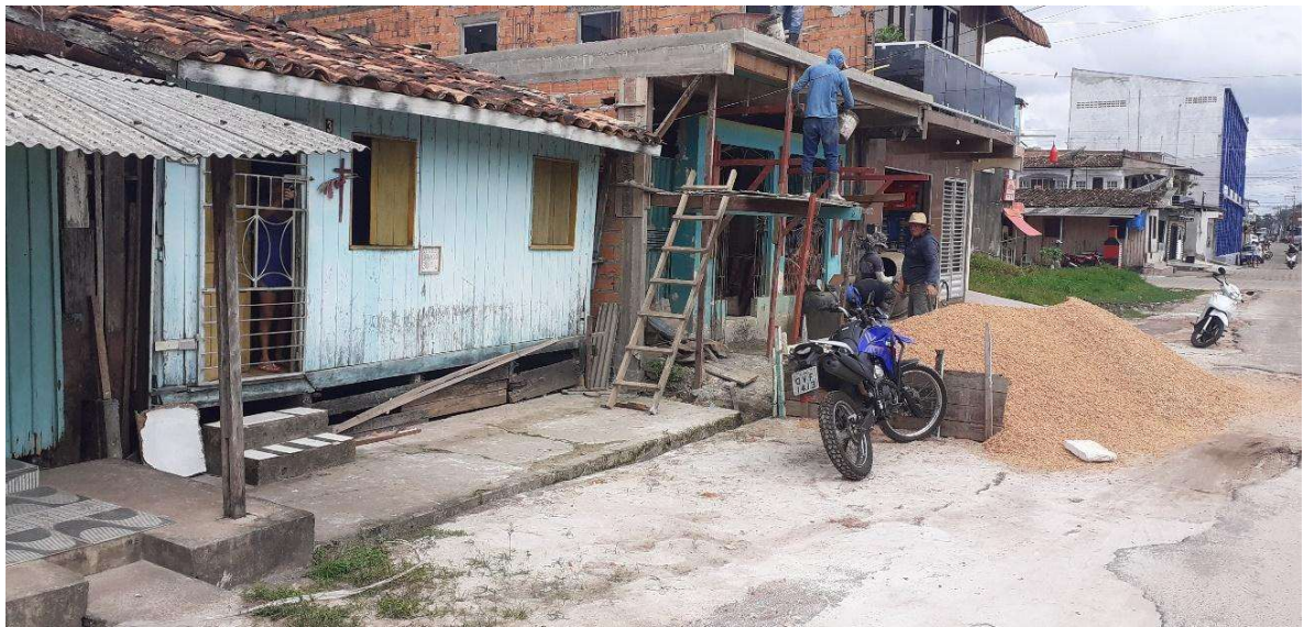
Figura 18 – Residências na Rua José Augusto Corrêa. Construção antiga e recente mantendo o nível acima das vias.
