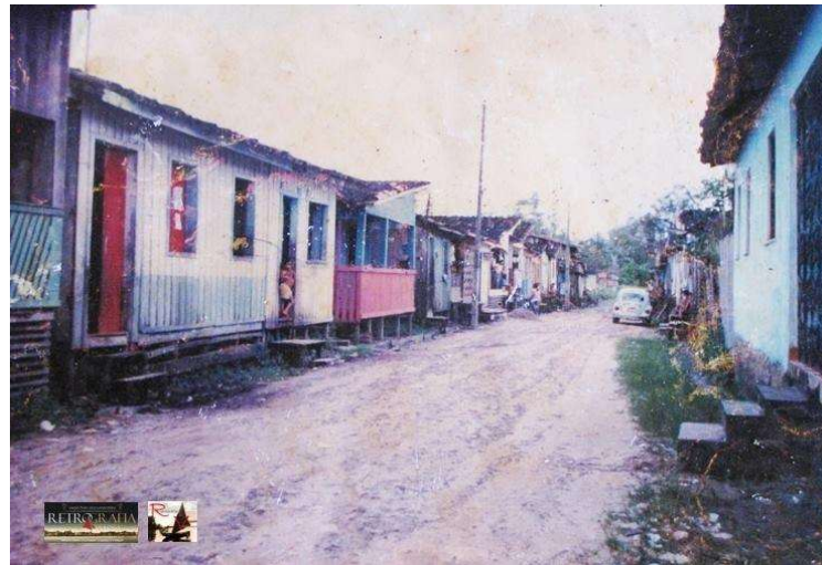
Figura 15 – Rua Nazaré, próximo ao Educandário, década de 1990. Habitações com nível adaptado às inundações.
