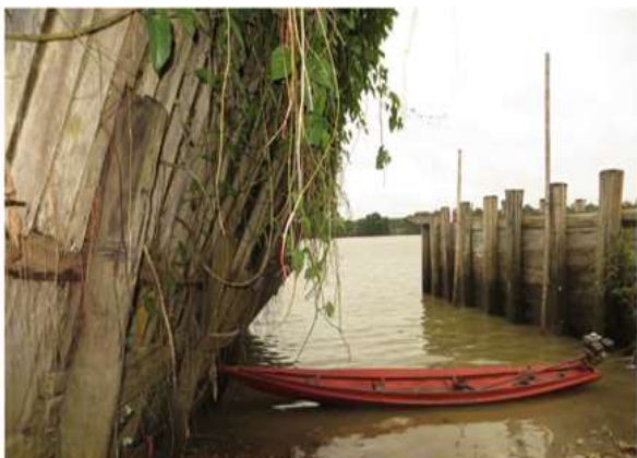
Figura 12 – Vista frontal da Trav. D. Pedro I
