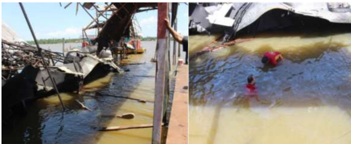
Figura 39 – Destroços causados pela explosão da balsa de combustível durante serviço de retífica
