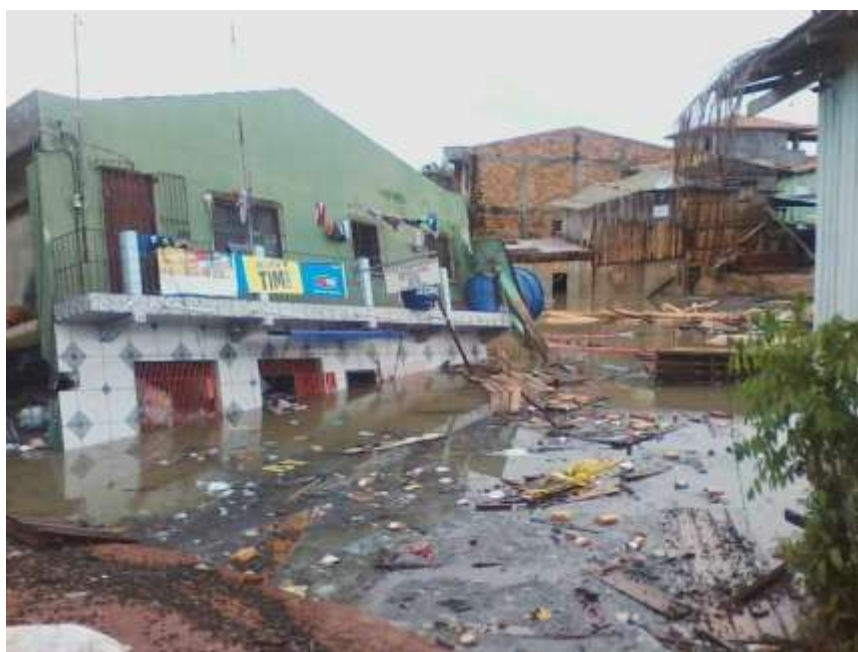
Figura 19 – Imóvel de 2 pavimentos em área de solo fragilizado
