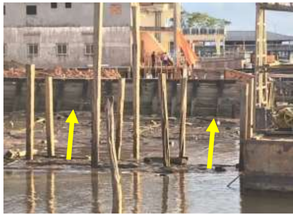
Figura 17 – Áreas particulares com contenção em madeira
