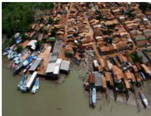
Figura 11 – Imagem aérea do desastre no bairro São João
