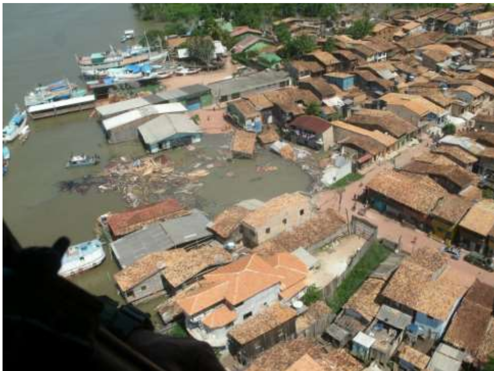
Figura 18 – Área colapsada no bairro São João em 2014
