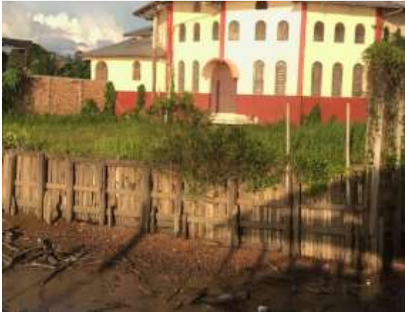
Figura 16 – Fundos da Igreja de São José
