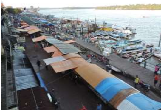
Figura 41 – Foto panorâmica da orla de Abaetetuba antes da obra
