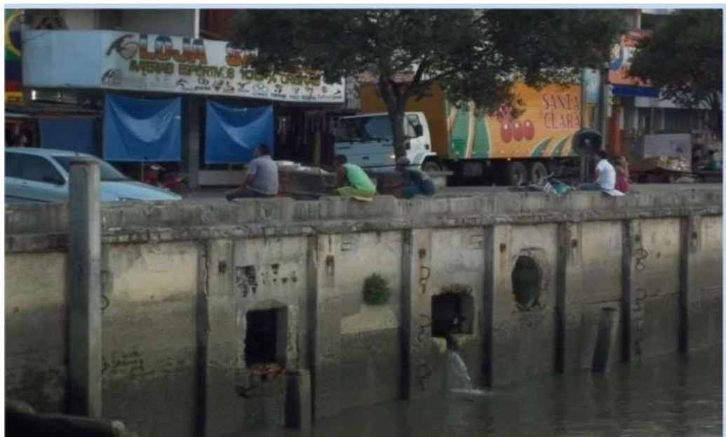
Figura 7 – Destino final do sistema de drenagem pluvial na orla de Abaetetuba
