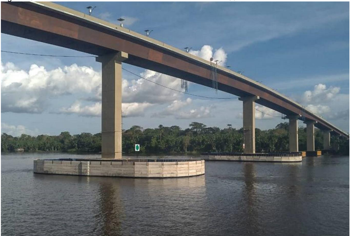
Figura 15 – Ponte sobre o Rio Acará localizada no km 44 da PA-483
