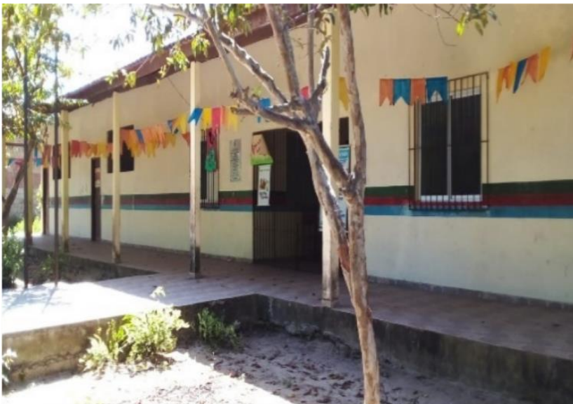
Figura 29 - Prédio escolar da comunidade de Tomázia
