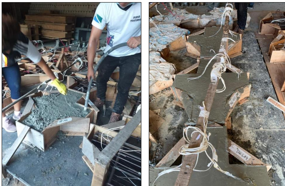
Figura 3.12- Concretagem e adensamento dos espécimes.
