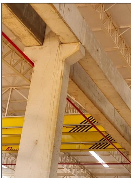
Figura 1.2- Consolos de concreto armado do Galpão da SOTREQ CAP.
