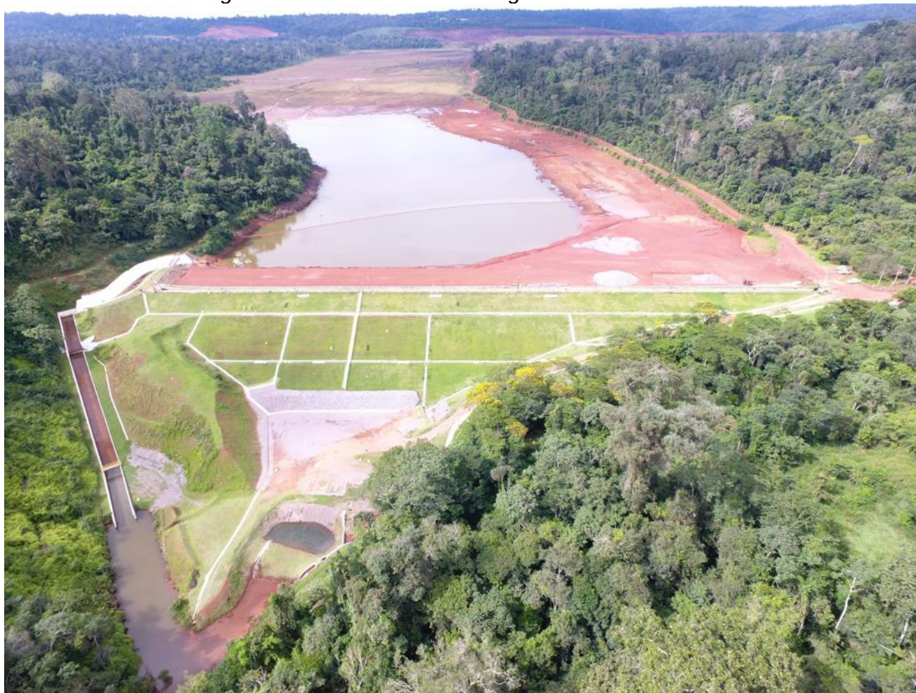
Figura 9 – Foto aérea da Barragem em estudo
