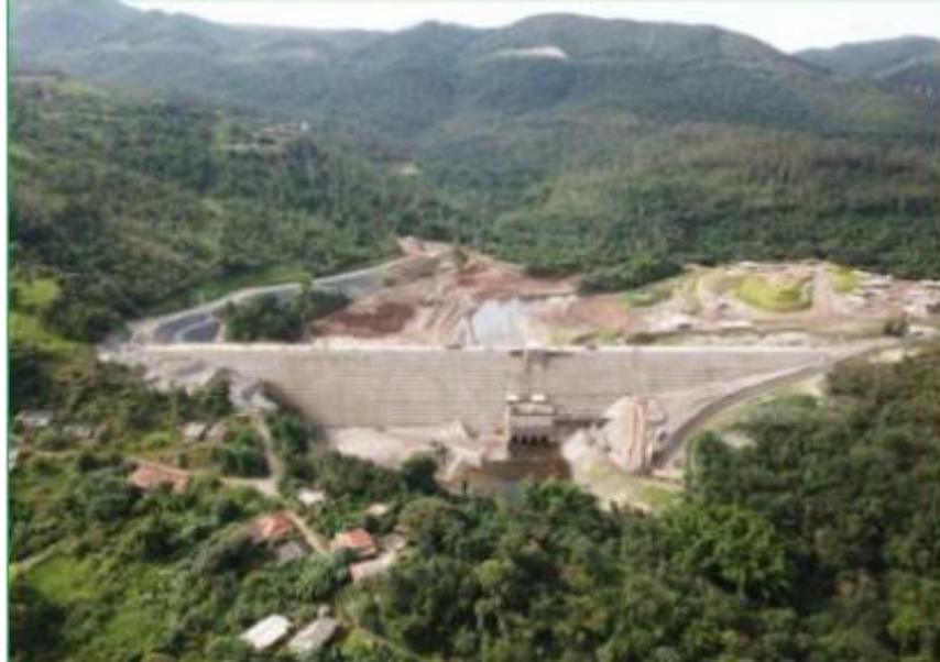
Figura 5 – Estrutura de contenção a jusante do maciço existente
