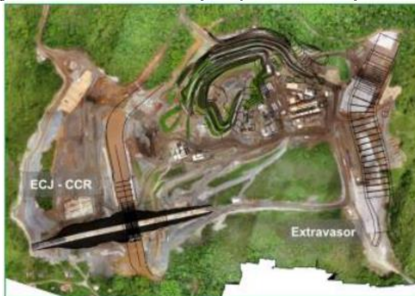
Figura 6 – Estrutura de contenção a jusante do maciço existente
