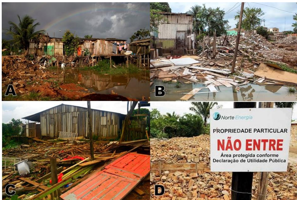
Figura 26. Casas Demolidas nos Baixões de Altamira
