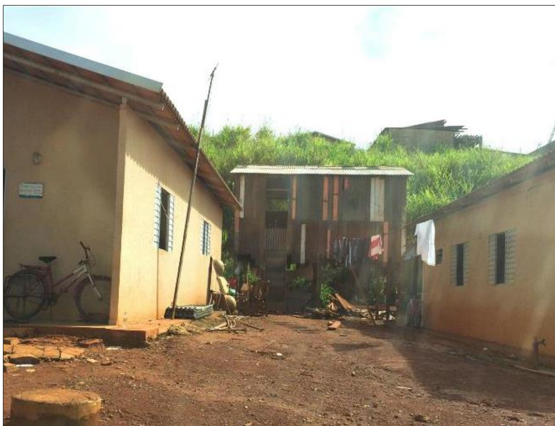
Figura 14. Palafita construída no RUC São Joaquim Fonte: Miranda Neto, 2015.
