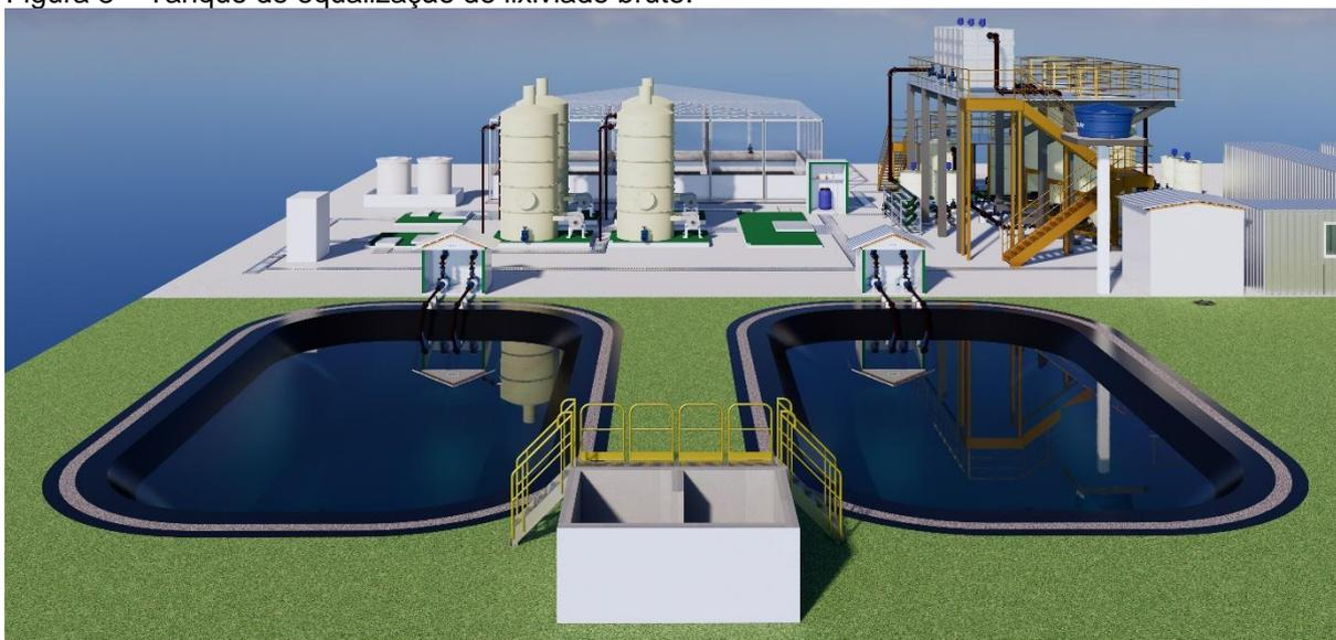
Objetivando maior flexibilidade operacional, o tanque de equalização de permeado e concentrado da osmose reversa terão o mesmo volume do tanque de equalização de lixiviado bruto, tendo o seu dimensionamento análogo ao que foi apresentado nas equações 04 a 13.
