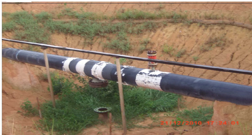
Fotografia 9 - Mineroduto na Colônia Beira Rio KM 23 Foto da própria autora. Pesquisa de campo (2010).
