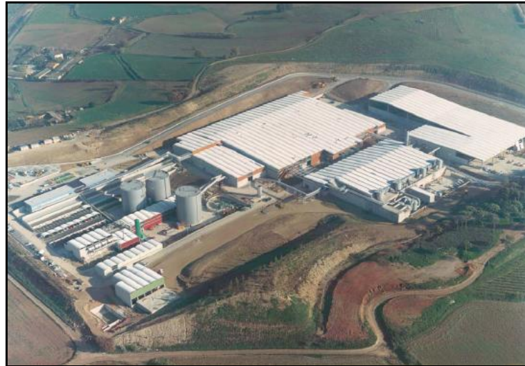
Figura 16 – Vista aérea das instalações do Ecoparque 2 em Barcelona (ES). Fonte: EMB (2005).
