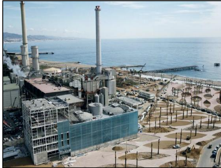
Figura 8 - Incinerador de RSU na região metropolitana de Barcelona. Fonte: EMB (2005).
