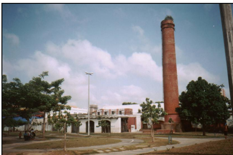
Figura 70 - Incinerador construído pelos ingleses em 1900, Belém (PA). Fonte: W3C (2006).
