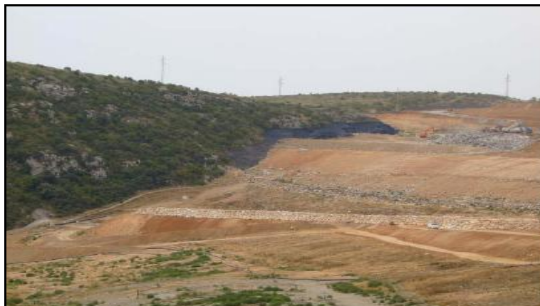
Figura 22 - Vista do aterro sanitário de Garraf. Fonte: EMB (2005).
