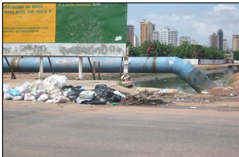
Figura 27 - Rua Fernando Guilhon c/ canal da Generalíssimo, Belém(PA).
