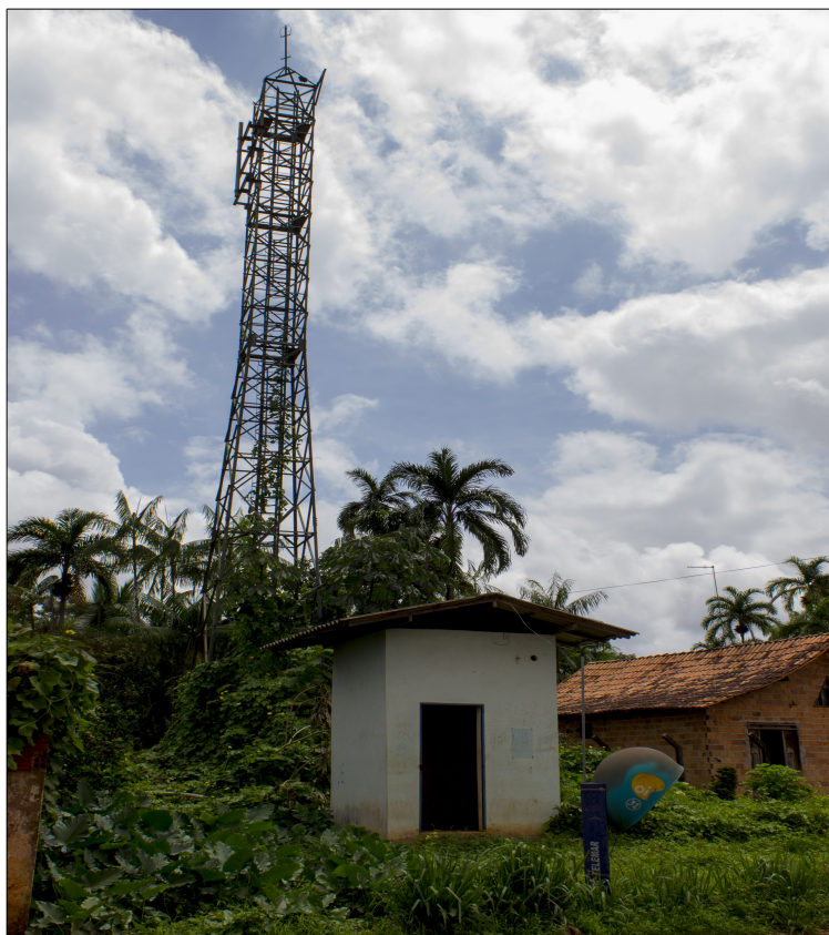
Figura 4.17 - Torre abandonada da Oi em Itabocal – Irituia – PA (Fonte: próprio autor).
