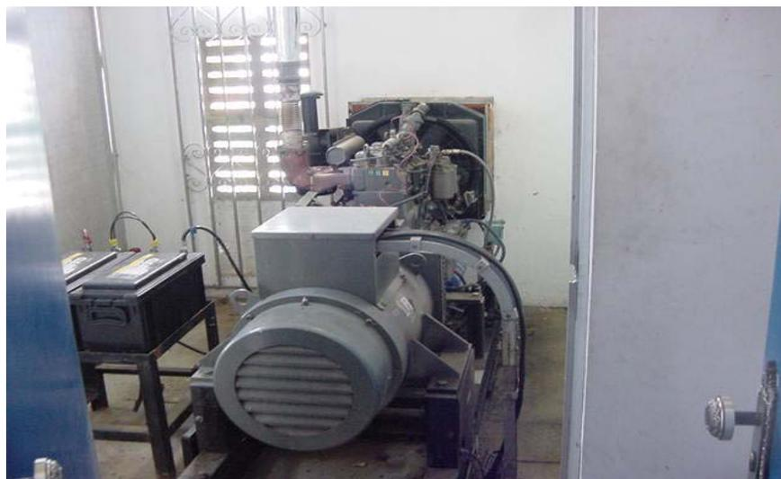
**Figura 1.10.** Os geradores a diesel requerem acomodação em sala própria.
