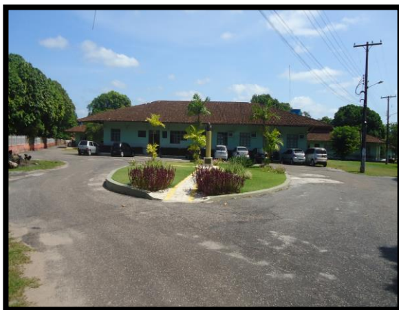
Fig. 3 - Fachada de Entrada do Abrigo João Paulo II
