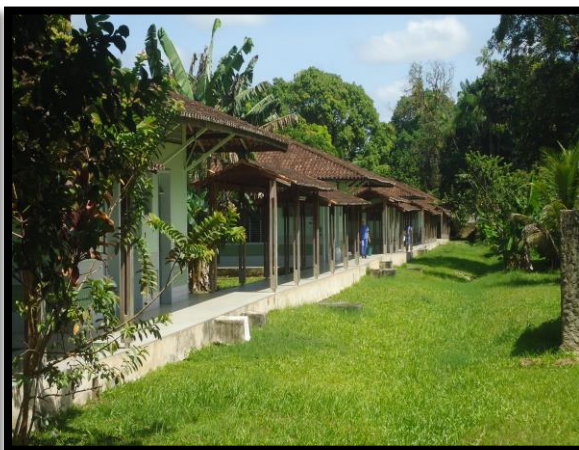
Fig. 4 - Passarela do Bloco Masculino (1)
