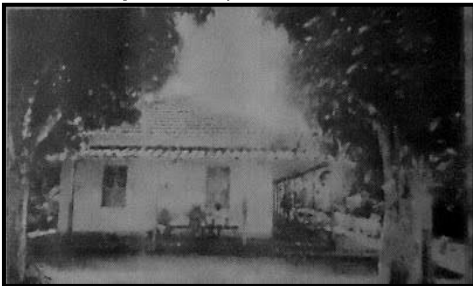
Fig. 32 - Pavilhão de alojamento – Colônia de Marituba
