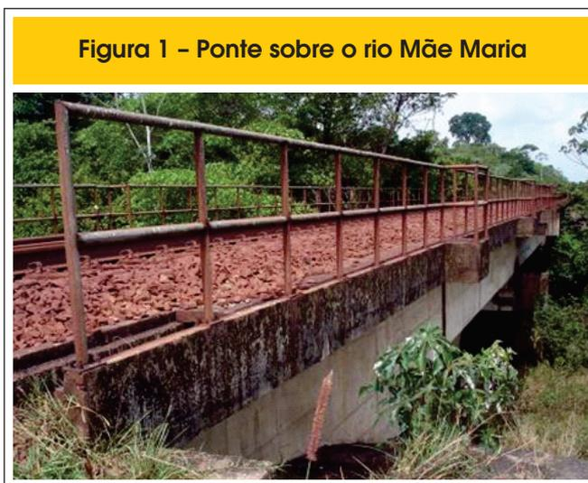
0,70 m no apoio dos Encontros e do Bloco B2, como mostra a Figura 2, enrijecidas por vigas transversinas (secundárias) intermediárias que se apoiam em aparelhos de apoio em neoprene fretado, no encontro E1 e no bloco B2. No encontro E2, a viga é engastada. A Figura 3 mostra o sistema estrutural geral com vigas, encontros, blocos e tubulões em concreto armado moldado “in loco”.
