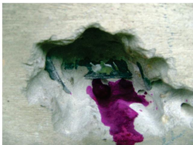
Figura 13 – Extração de testemunho de concreto
