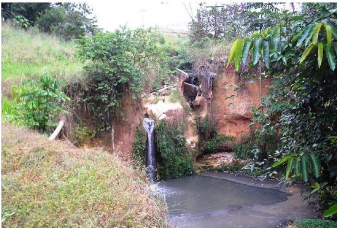
Figura 09: Erosão Rua Bahia em 2013.
