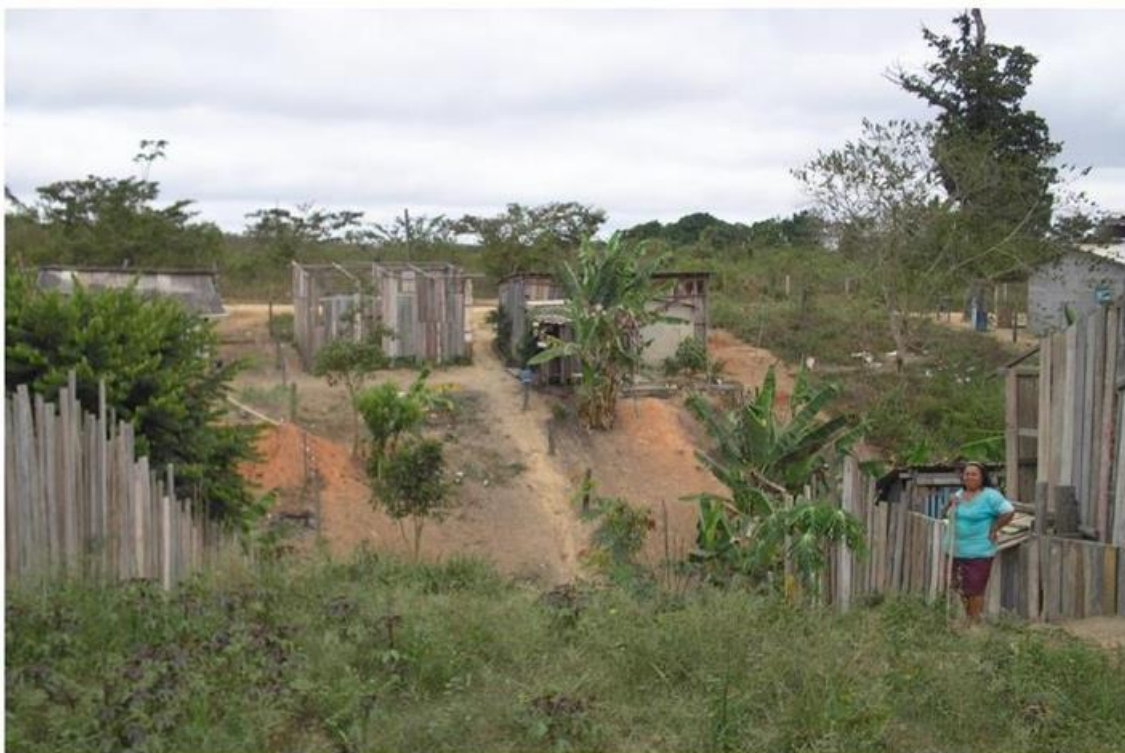
Figura 13: Erosão Novo Horizonte 02 em 2013.
