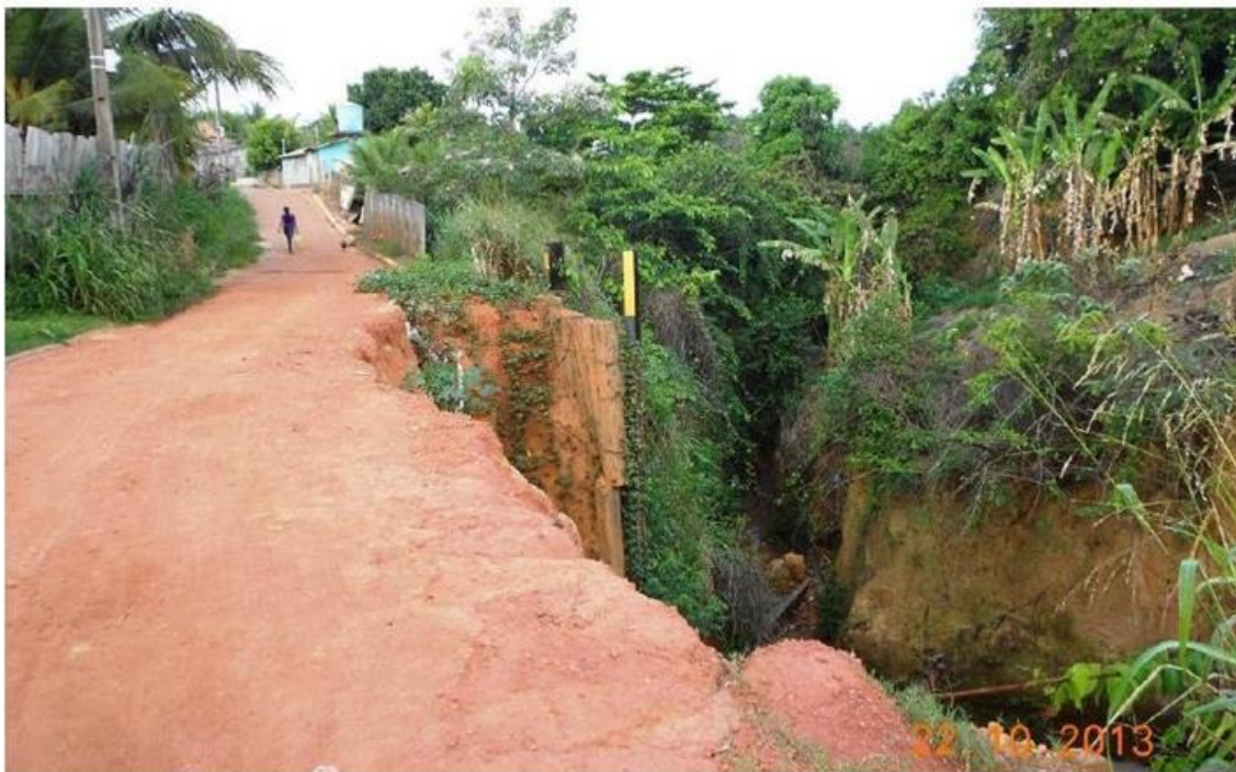
Figura 07: Erosão Rua Leandro em 2013.
