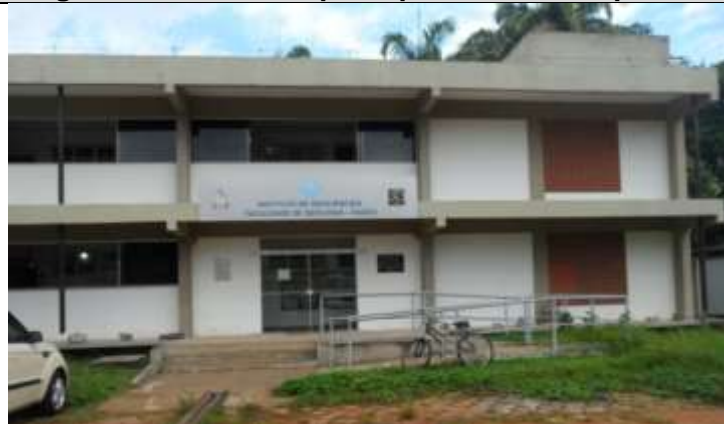
Figura 01 – Fachada principal: Acesso ao prédio.
