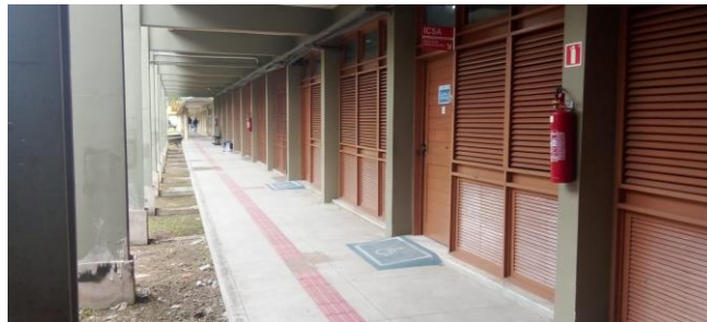
Figura 12 – Vista lateral das salas de aula da Uniterci
