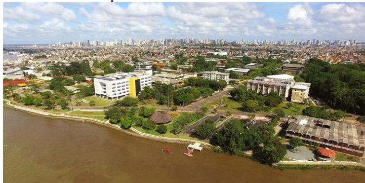
Figura 7 – Vista aérea da Reitoria no Campus da UFPA
