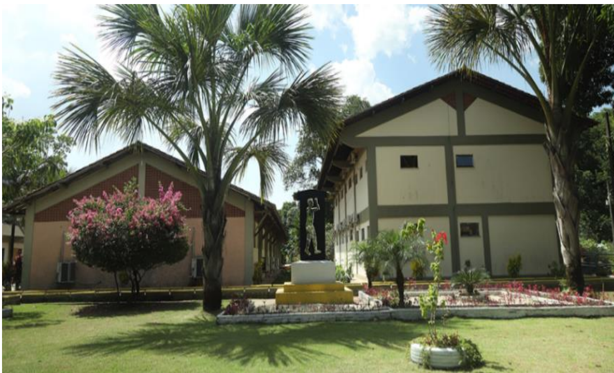
Figura 3 - Universidade Federal do Pará - Campus Abaetetuba
