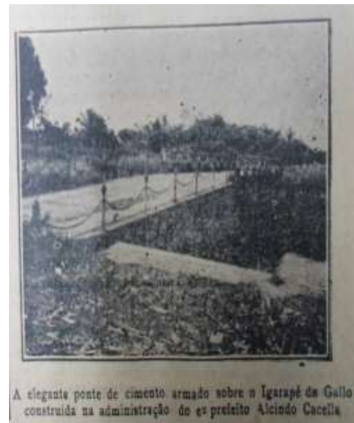
Figura 43 - Construção da Ponte do Galo.
