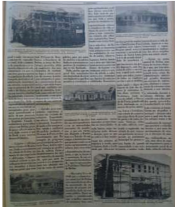
Figura 46 - Obras da prefeitura de Belém.
