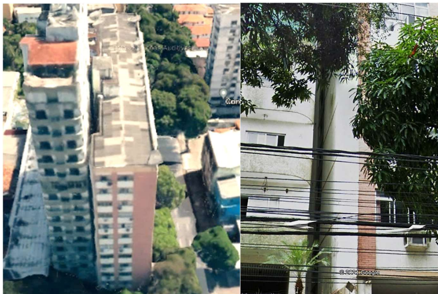
FIGURA 32. AUSÊNCIA DE RECUO: ED. LYGIA FERNANDEZ E ED. METRÓPOLE
