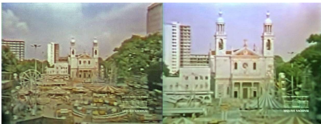
FIGURA 18. PRAÇA DO CAN E BASÍLICA DE NAZARÉ. AO FUNDO, EDIFÍCIOS AINDA EM CONSTRUÇÃO
