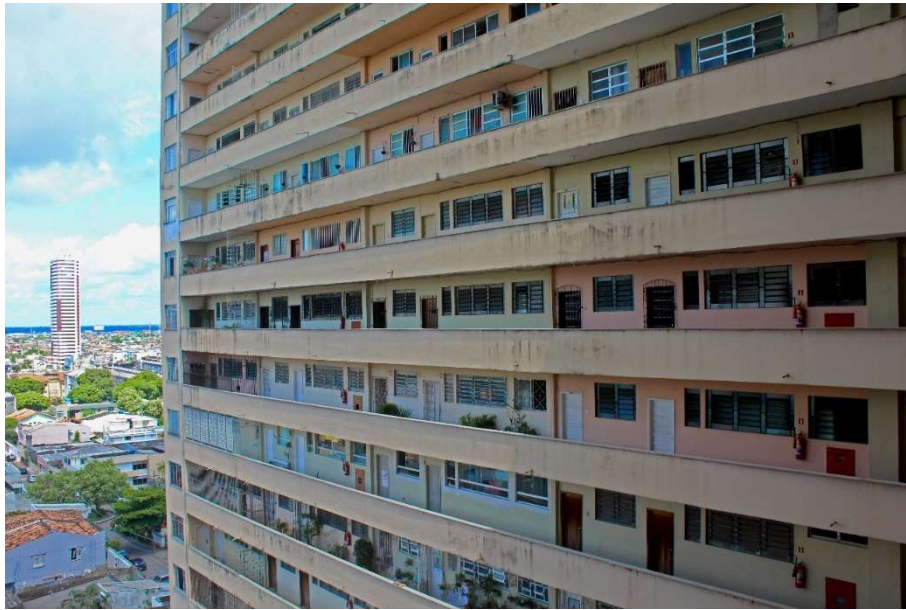
FIGURA 21. CIRCULAÇÃO INTERNA DO BANNA –PORTAS E JANELAS DOS APARTAMENTOS 06, 07, 08 E 09
