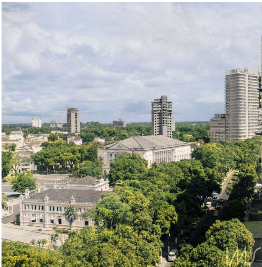
FIGURA 4. VISTA DOS PRÉDIOS DA AV. NAZARÉ AINDA EM CONSTRUÇÃO, c.1966
